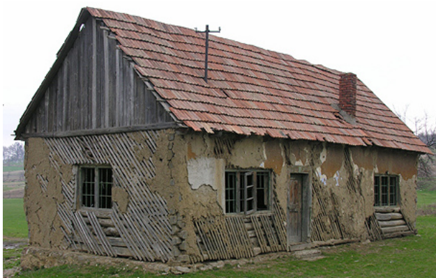
Obr. 5: Rumunský Bihor (Varzaľ): stavebná technika objektu z pol. 20. stor. Autor: P. Chrastina (4.4.2006)
