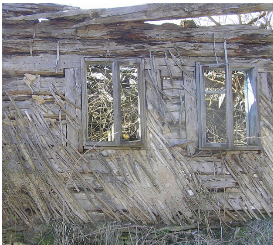
Obr. 4: Levočské vrchy (zaniknutá dedina Podproč): stavebná technika objektu z 19. stor. Autor: J. Brincko (31.3.2007)
